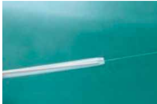
Fig. 3.5.2.1 Colocar manga termocontráctil
